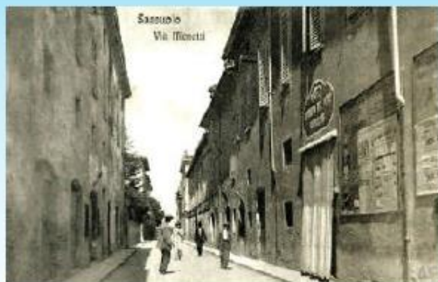
Via Menotti deposito Sassolino anni '20
