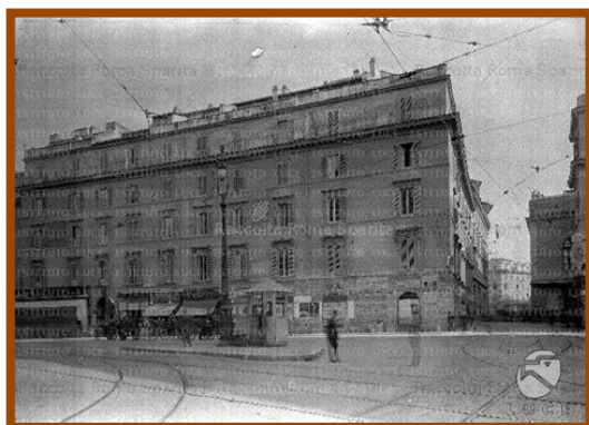
Palazzo di Torre Argentina
